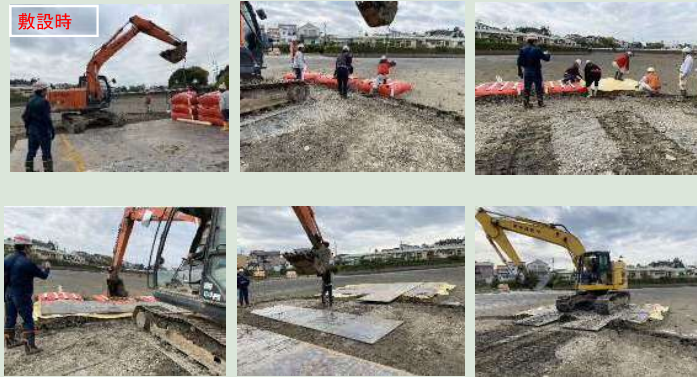
【愛知県:D-Box工法の試験工事】超軟弱地盤(ヘドロ)上にD-Box-LS150を1段3列敷設(ユンボの基礎) 2023.11
