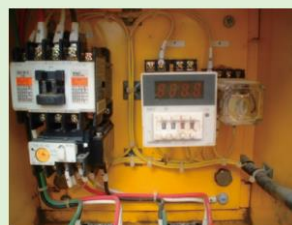
従来型水量計の調整箇所
