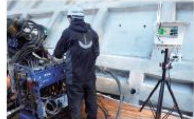
削孔長計測状況
