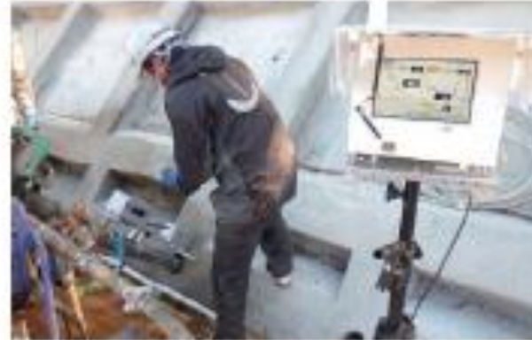
削孔角度方位計測状況
