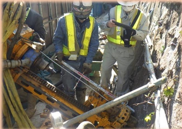
削孔後に検尺棒で人が計測
