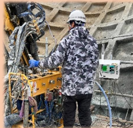
削孔時に自動でリアルタイム計測
