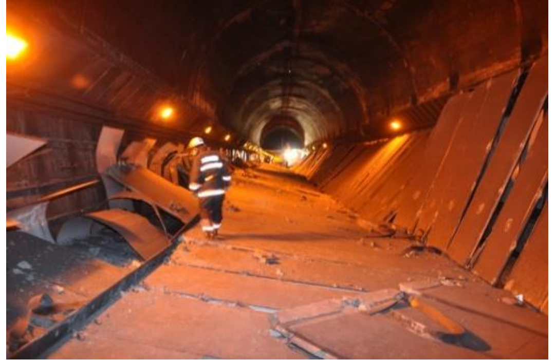
笹子トンネル(中央自動車道) 2012年天井板落下 (開通後35年経過)
