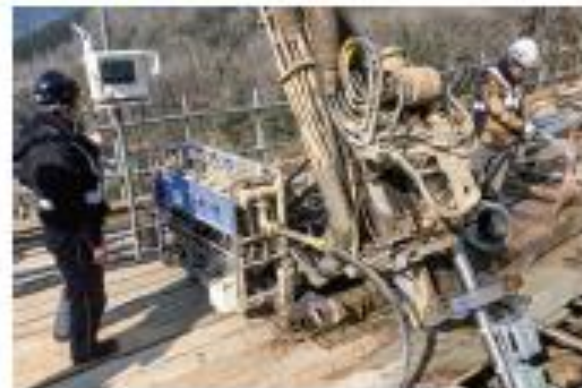
削孔角度方位計測状況
