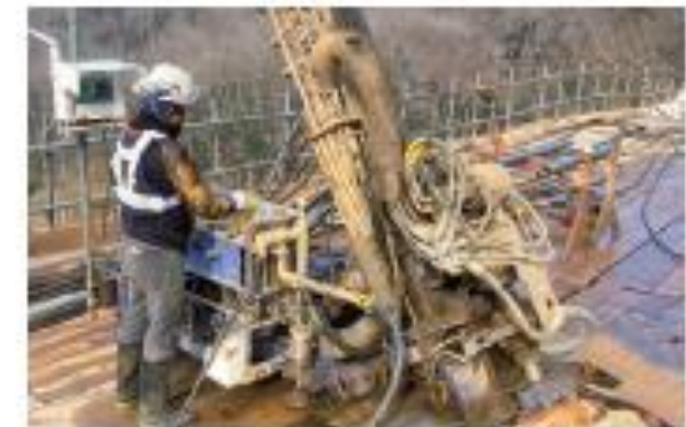
削孔長計測状況
