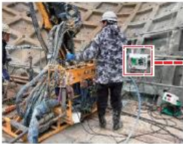
削孔計測及び計測画面
