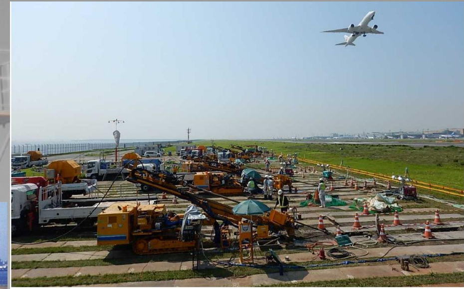
滑走路地盤改良【東京空港整備事務所】
