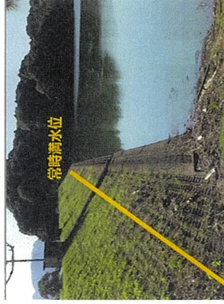
ため池の貯水量全体の約3割（20万m³）を洪水調節容量として確保。
