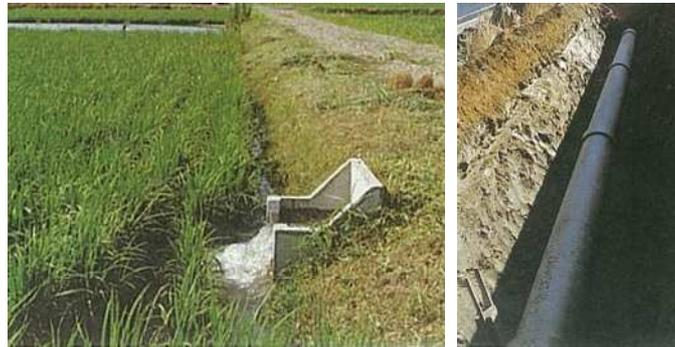
図Ⅲ-4 水田に設けられた給水栓と末端配管
