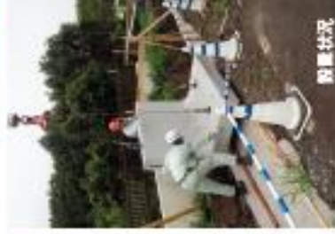
プレキャストL型防水壁設置
